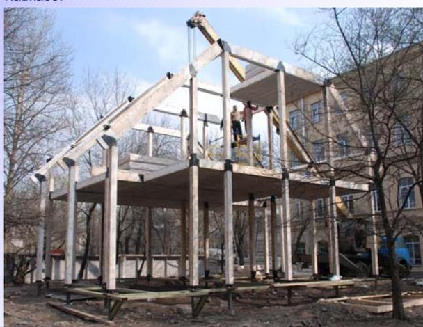
Монтаж деревометаллического каркаса быстровозводимого домокомплекта ОАО «ВНИИТМАШ» при строительстве офисного здания в Санкт-Петербурге.
