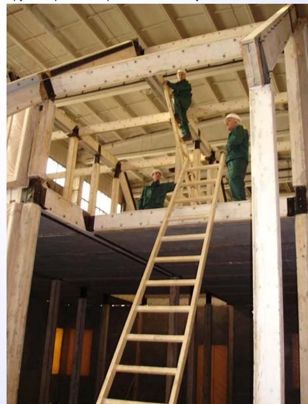
Контрольная сборка деревометаллического каркаса быстровозводимого домокомплекта ОАО «ВНИИТМАШ» перед отгрузкой покупателю.
